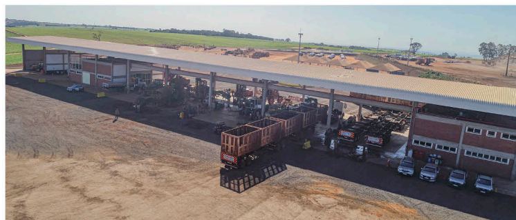
Novo prédio da Oficina Agrícola da Usina Buriti.
