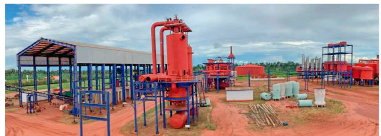
Parque industrial da Usina Cedro.
