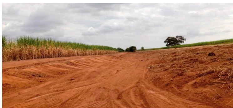
Manutenção e limpeza de aceiro, realizada pela Usina Buriti.
