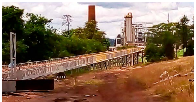
Esteira e tubulação por onde será conduzida a palha de forma pneumática
