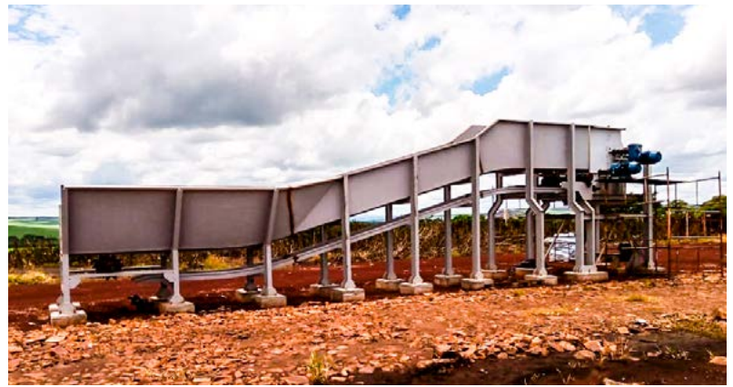
Obra de instalação do desenfardador de palha, equipamento que receberá o fardo de palha, na Usina da Pedra
