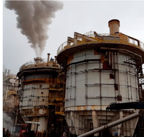
Decantadores e evaporador
