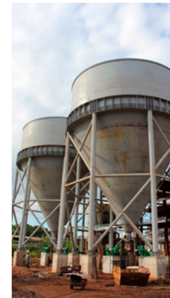
Sistema de tratamento de água e lavagem dos gases
