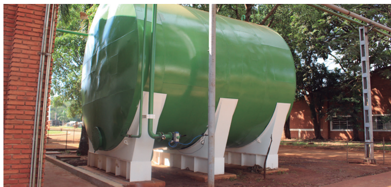
Tanque de armazenamento de água
