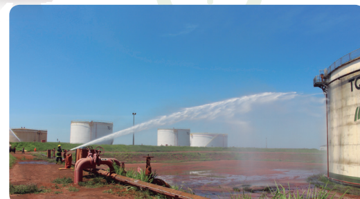
Hidrantes destinados para controlar as chamas nos tanques de etanol, em caso de incêndio
