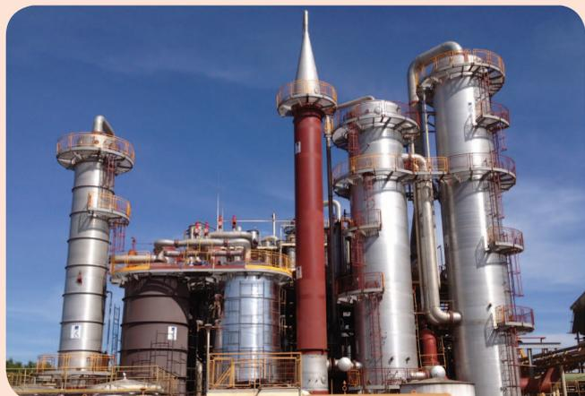
Novo aparelho de produção de etanol hidratado com capacidade de 600m<sup>3</sup>/dia e peneira molecular para etanol anidro com capacidade para 800m<sup>3</sup>/dia
