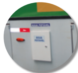
Local com água potável e sinalizações de segurança
